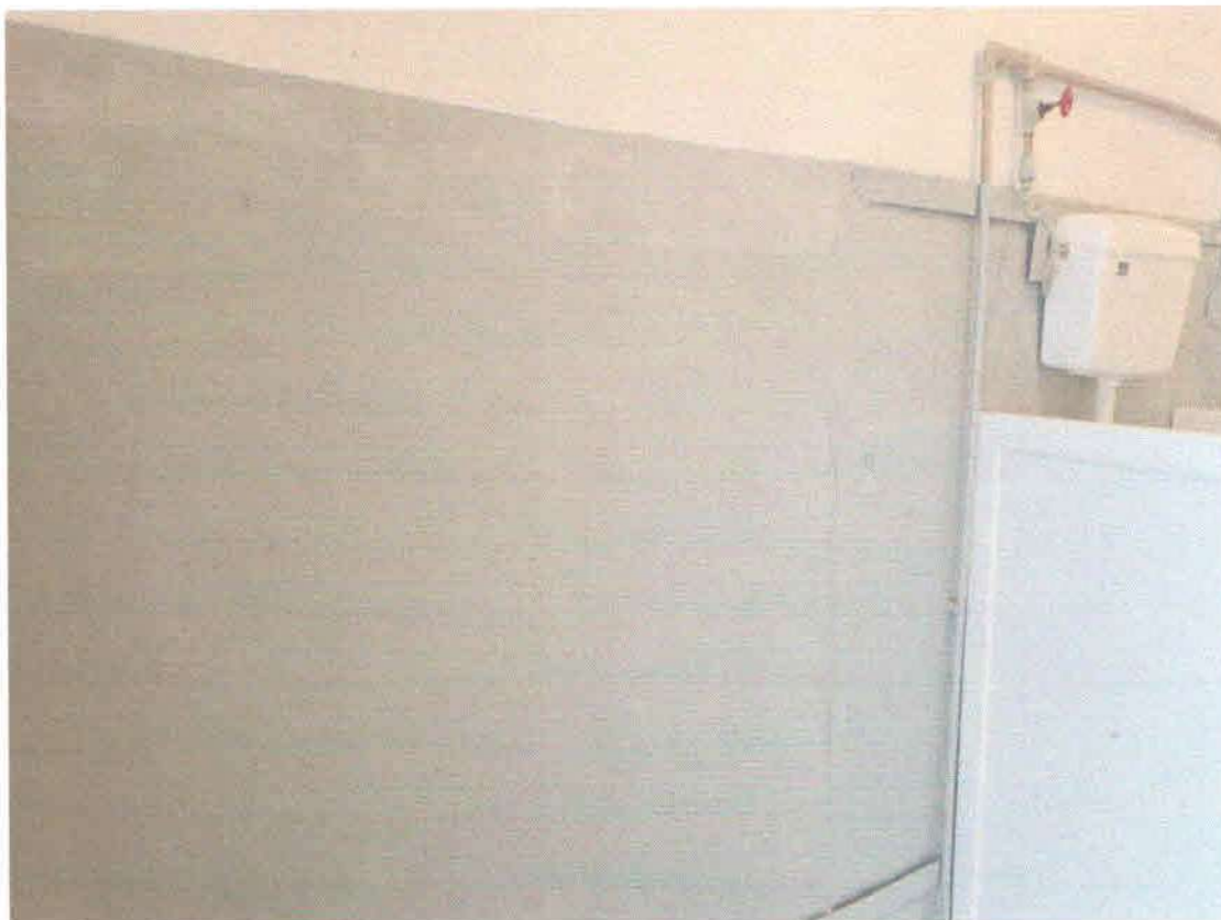
Рисунок 45. Состояние внутренней отделки
