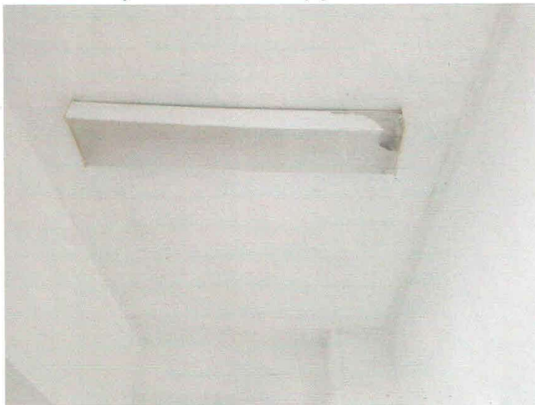
Рисунок 46. Состояние инженерных сетей
