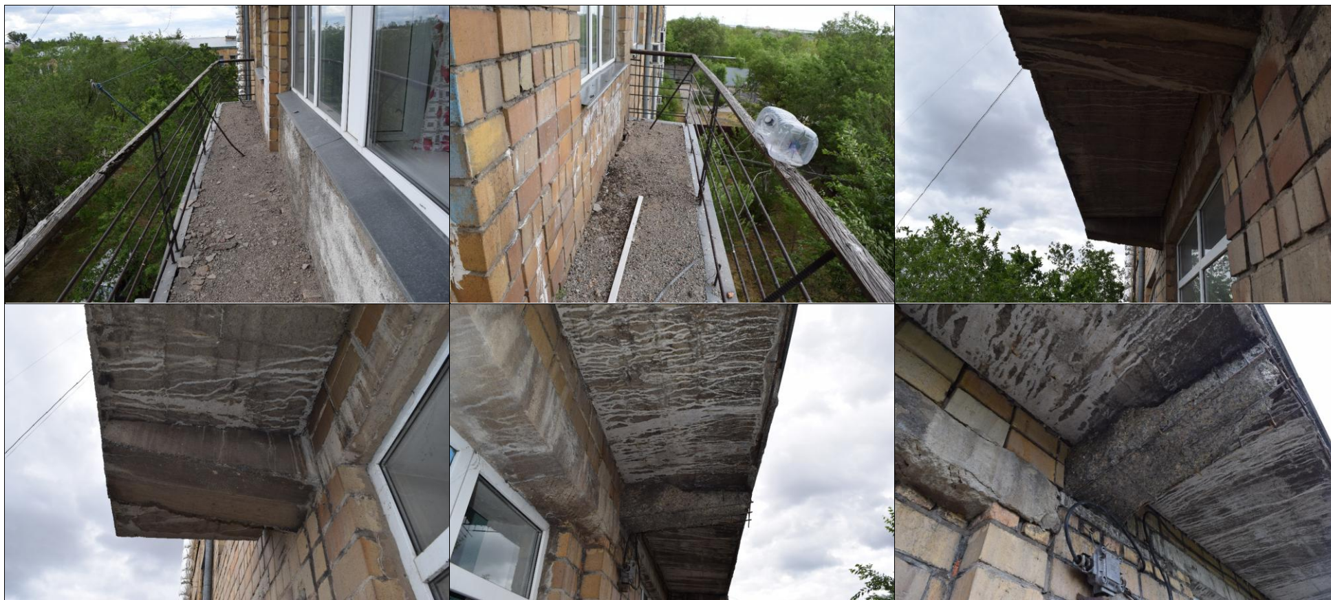
Фотоиллюстрации общих видов строительных конструкций балкона 3-го этажа.
