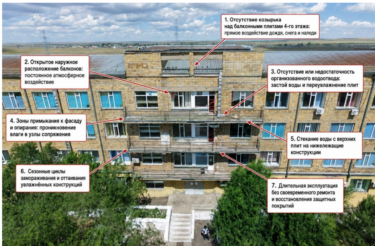
Фото 5. Факторы, способствовавшие образованию повреждений.
