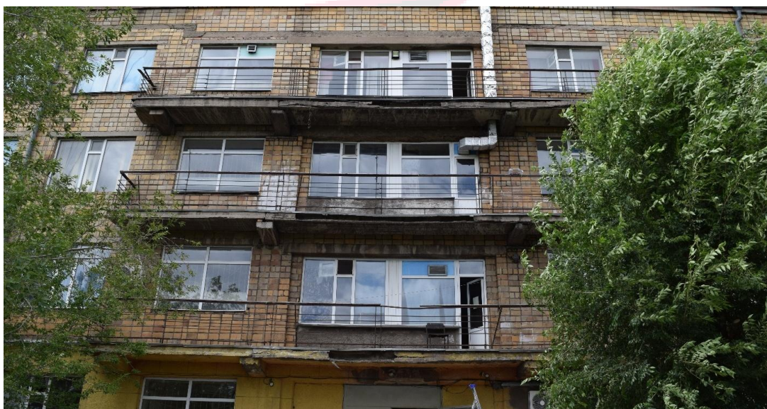
Фото 3. Общий вид фасадной части здания с расположением обследуемых балконных плит.
