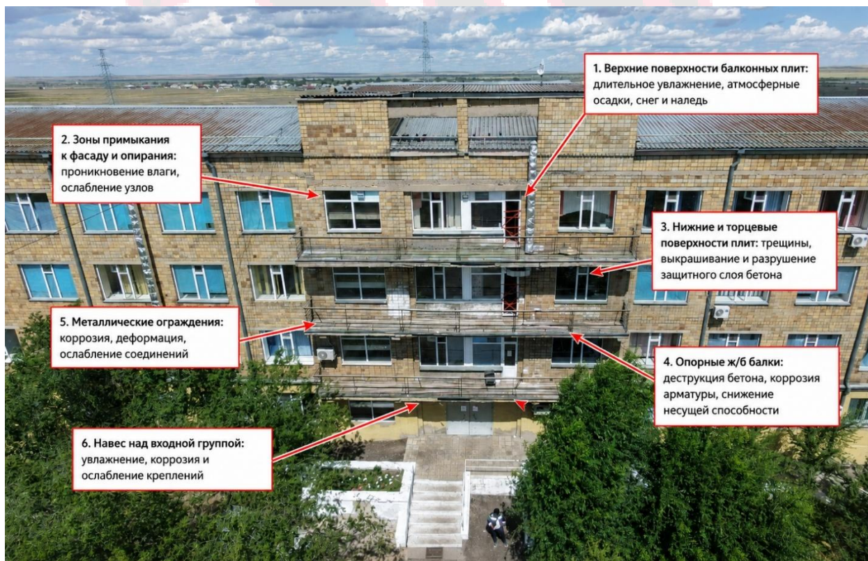
Фото 6. Участки и факторы, повлиявшие на снижение несущей способности.
