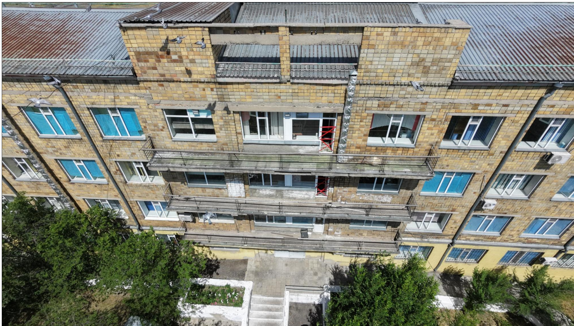
Аэрофотосъемка общего вида строительных конструкций балконов.
