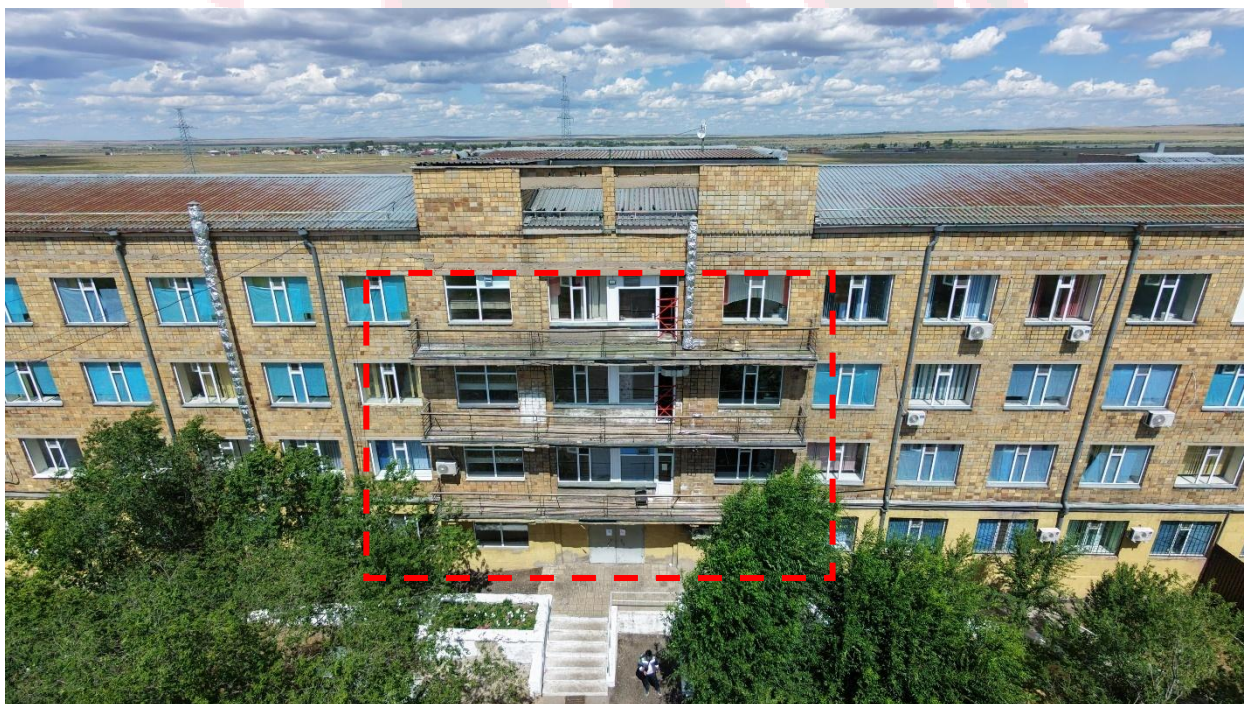
Фото 2. Общий вид обследуемого участка.
