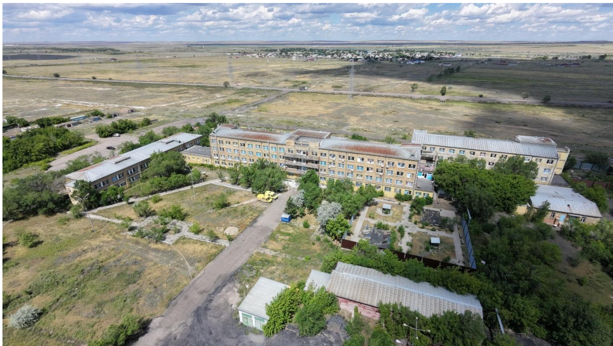
Фото 1. Общий вид здания.
