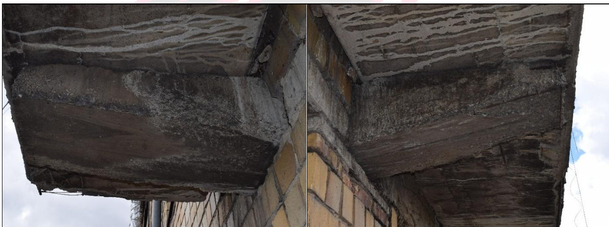
Фото 4. Вид снизу на балконную плиту и железобетонную опорную балку в зоне примыкания к наружной стене здания.
