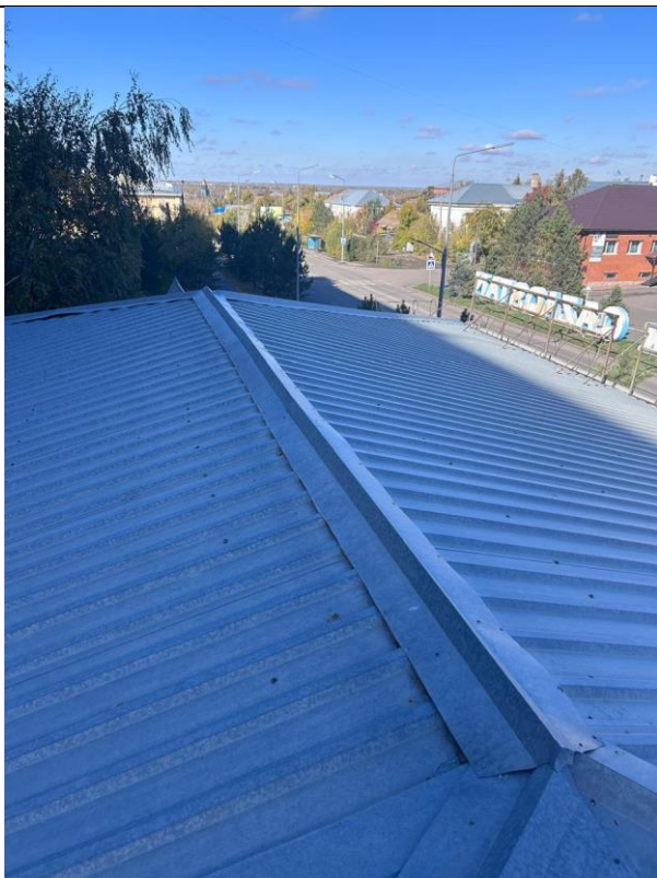
Крыша Литер А2. Состояние работоспособное
