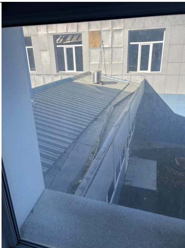
Покрытие галереи профлистом. Фасад Литер А2 деформирован
