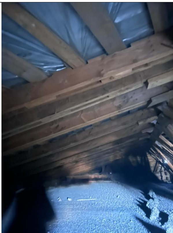
Стропильная часть Литер А2
