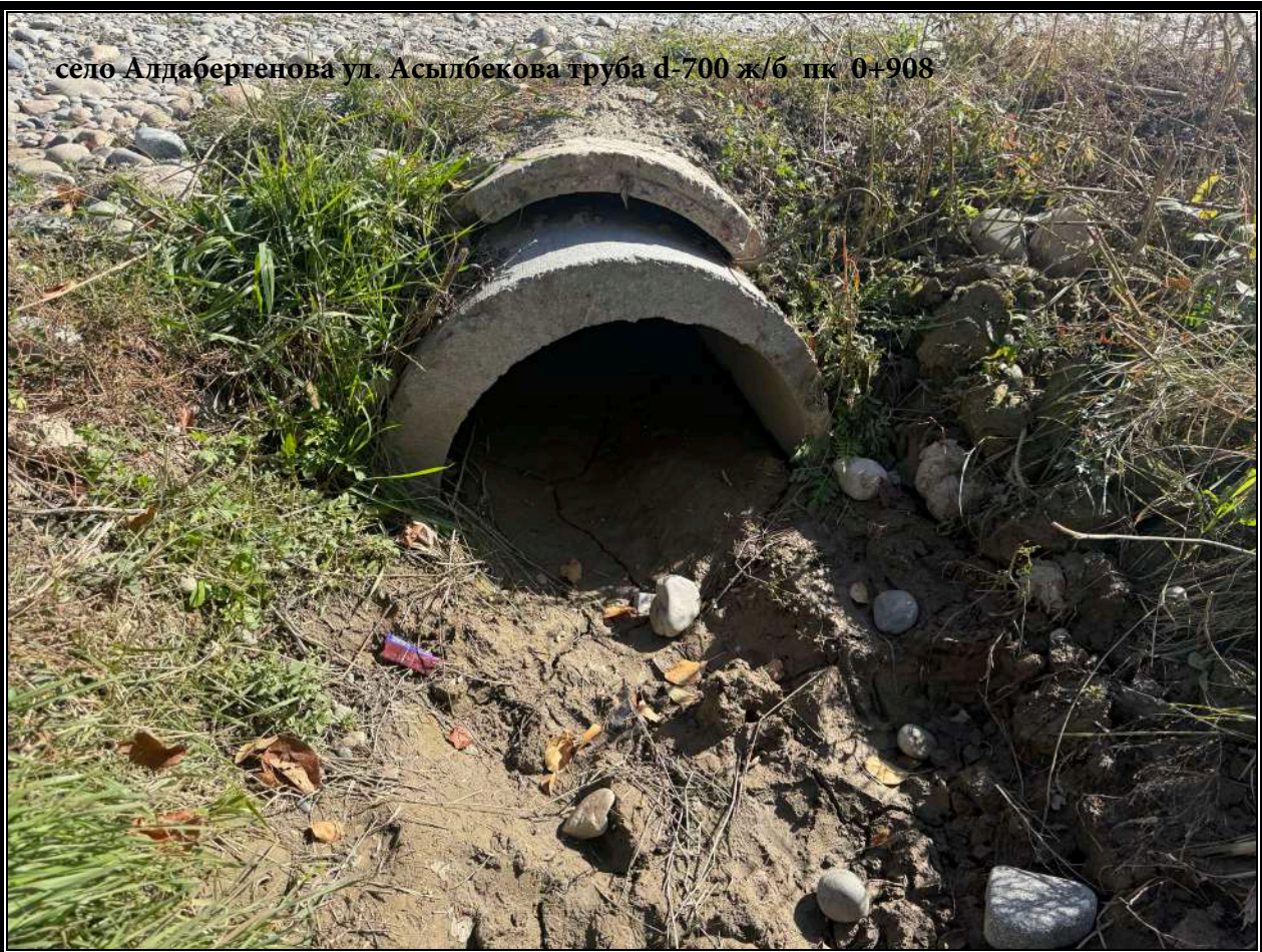
село Алдабергенова ул. Асылбекова труба d-300 ж/б пк 1+122
