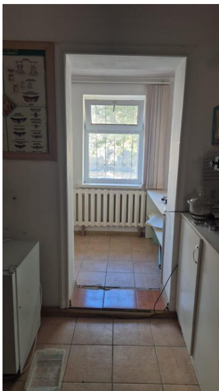
Фото заказчика. Установка двери в существующий проём.
